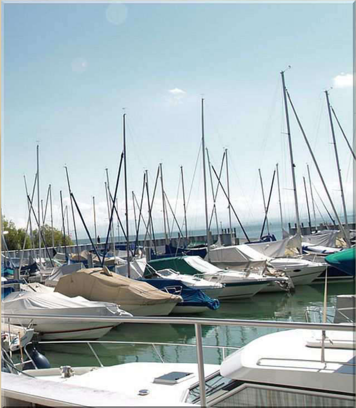
Hafeneinfahrt zwischen den Spundwänden
