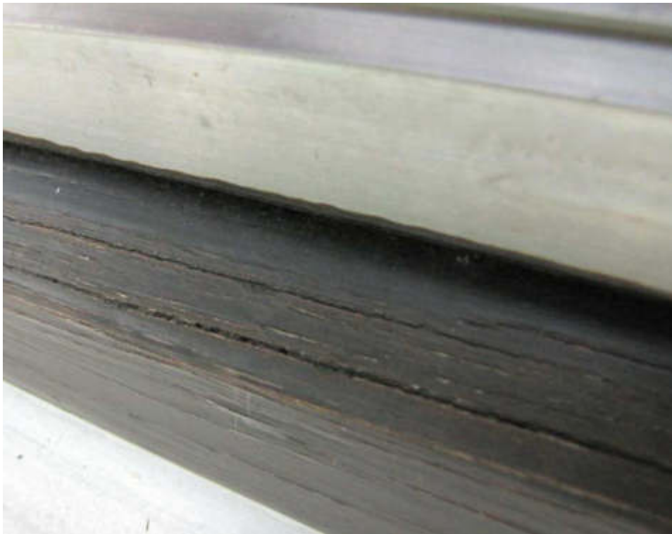
Das eigentliche Objekt der Sanierung
