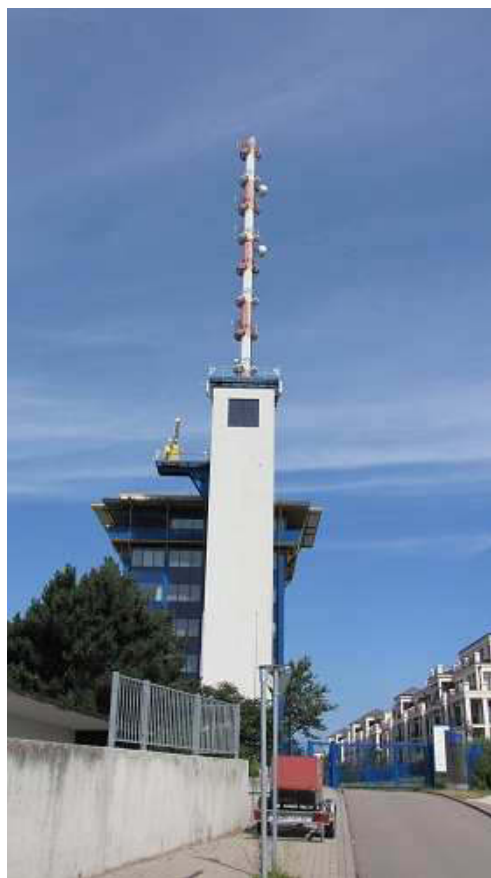
Funkturm des Wasser- und Schifffahrtsamts des Bundes am Fährenparkplatz
