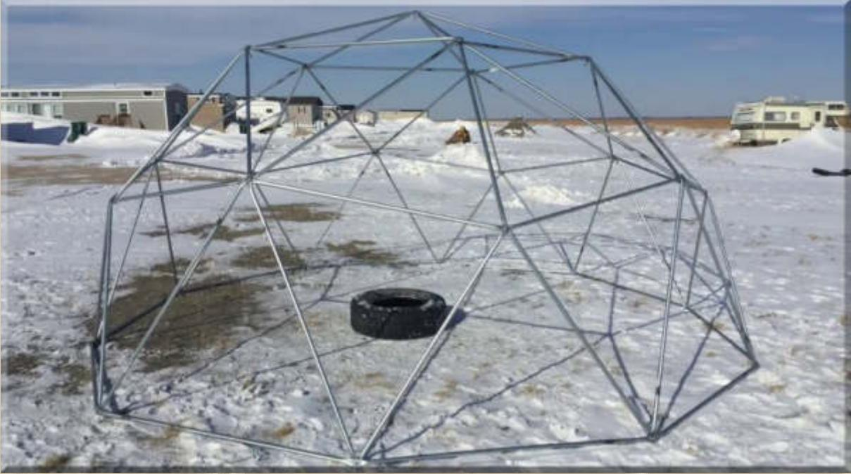
.... hier aus verzinktem Stahlrohr - Verbindung ganz einfach mit Gewindeschrauben, Unterlegscheiben und Mutter zusammenstecken und verschrauben:
