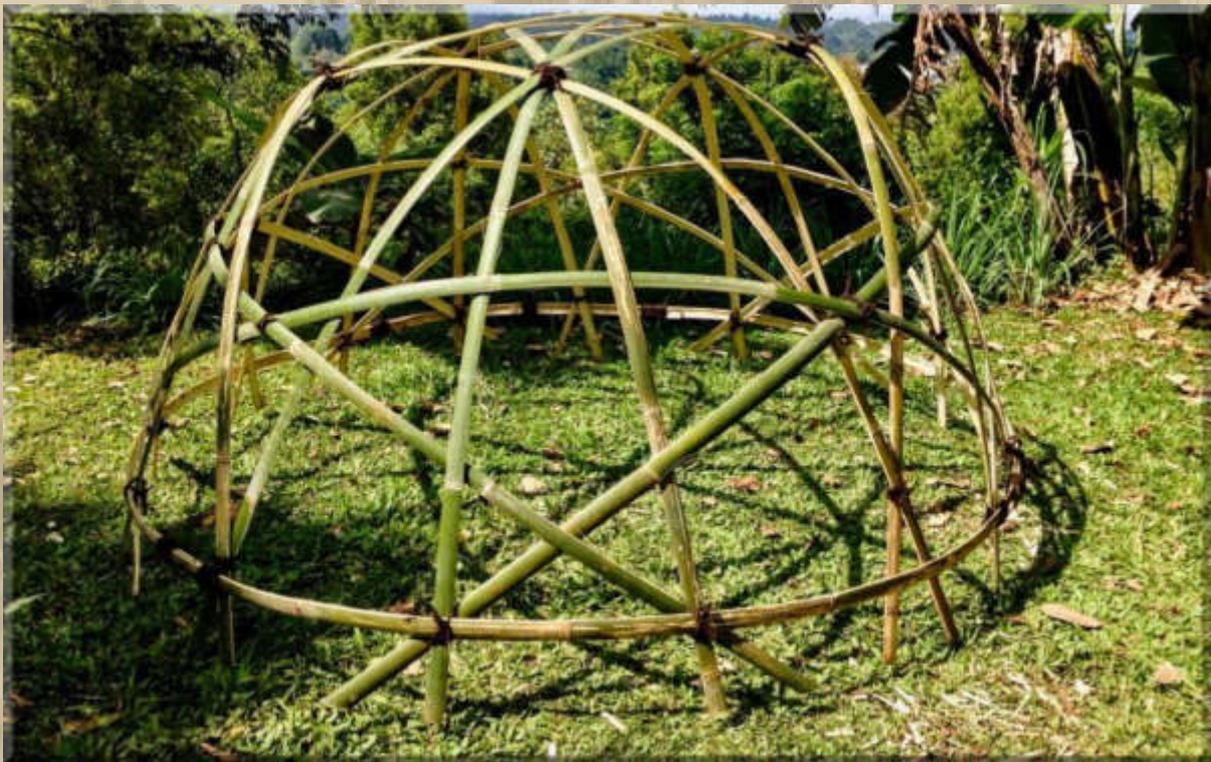
.... hier aus 12 gleichen Bambuslängen (2 für den Bodenring, 10 für die Bögen).
