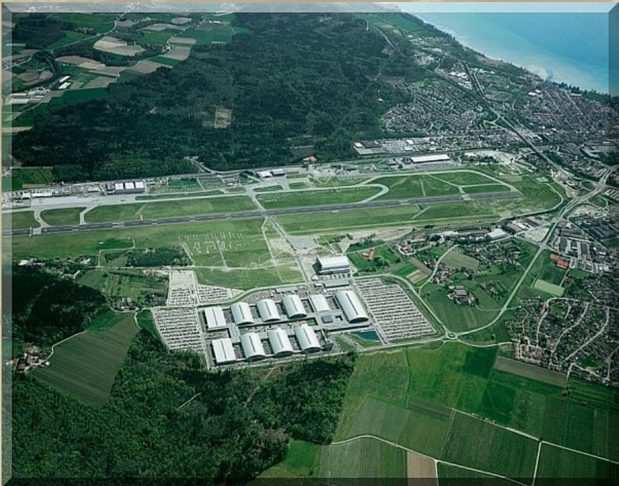
Flughafen mit Messegelände von NW gesehen
