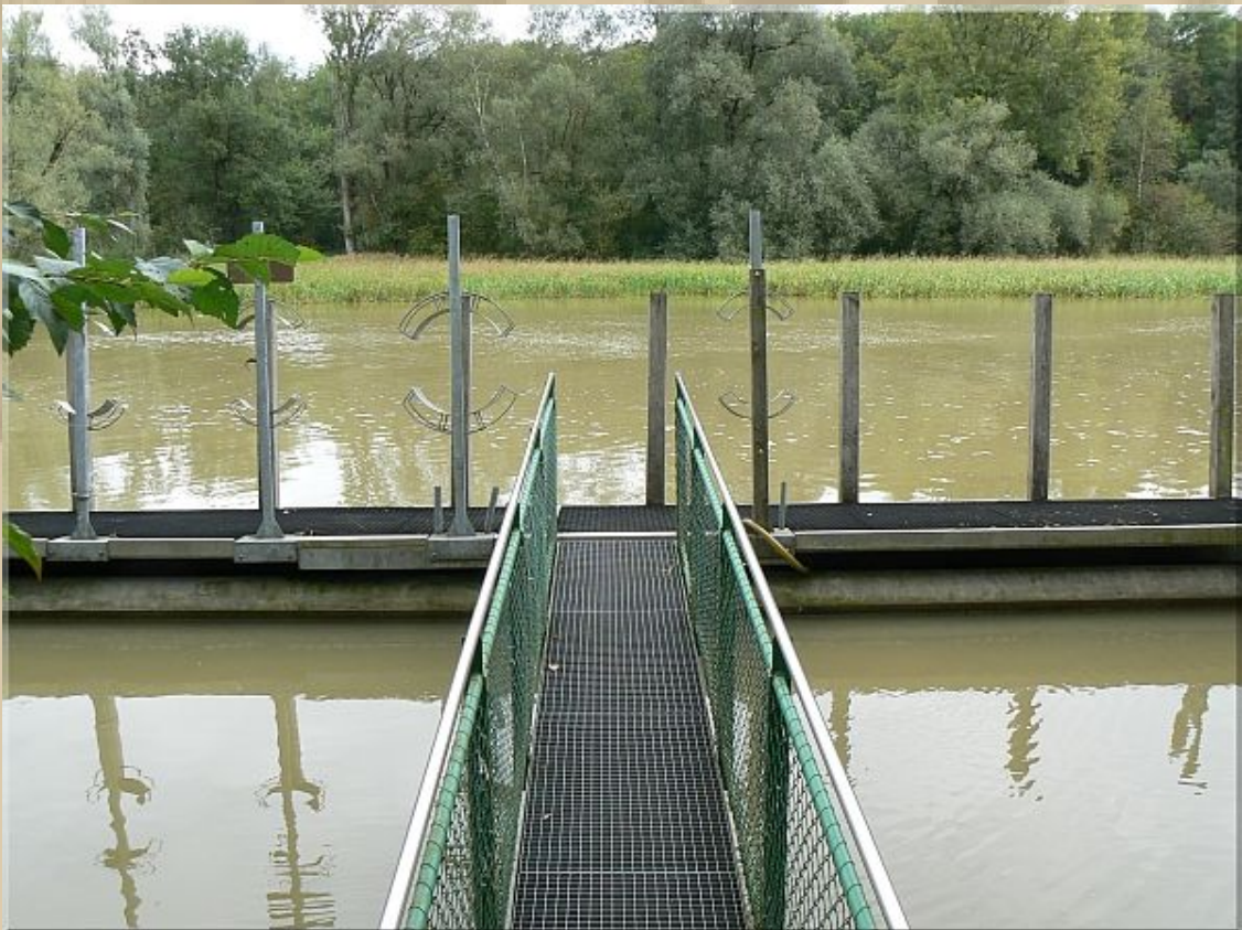
.... die älteste Bootsabpumpstation am Bodensee ( außer Betrieb )
