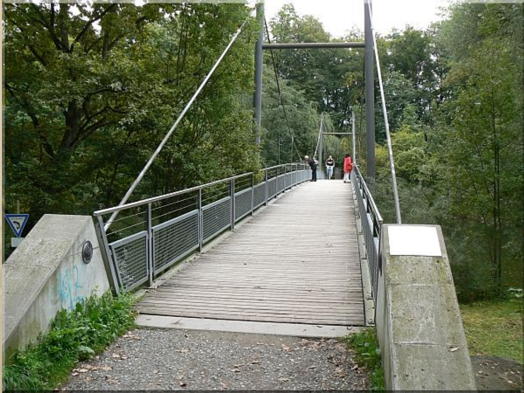
Diese Brücke über die Argen verbindet die beiden Häfen Meichle & Mohr und Muräne Kies.
