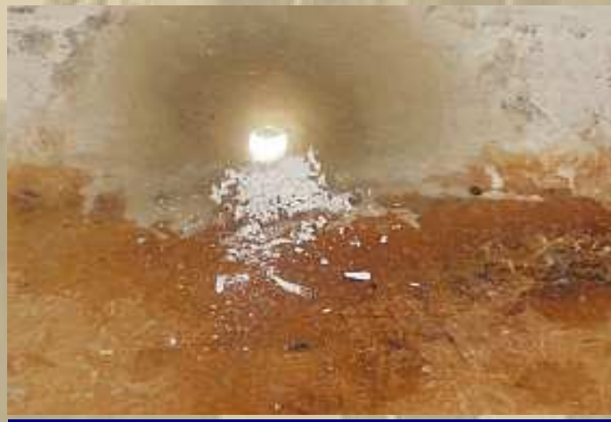
das Sicherheitsloch im Gasflaschenfach
