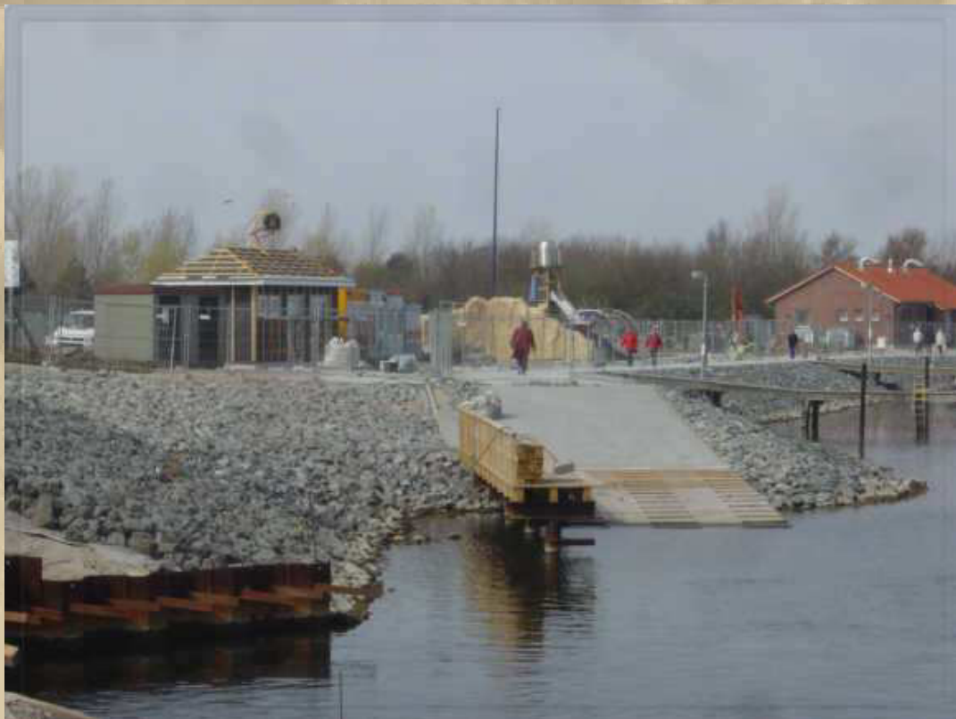
die neue Slipanlage am Steg 6, das unfertige Hafenservicehaus - das Richtfest war gestern u. der Abenteuerspielplatz
