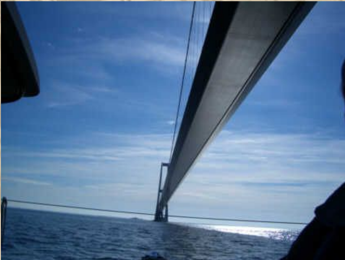
..... der mittlere Teil von 18 Km Beltbrücke - Durchfahrtshöhe 65 m
