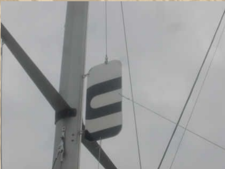
... eine gute Lösung zum Problem von Mastvibrationen
